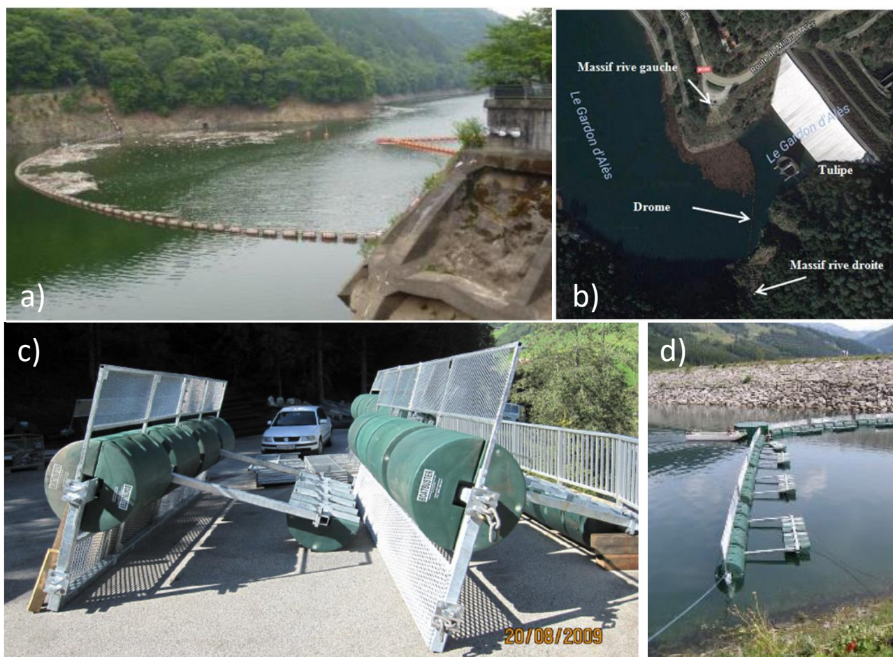
FIGURE 4.10: Exemples de barrages flottants : a) boudins flottants (source : ICOLD, 2019) ; b) drome installée en amont du barrage de Sainte-Cécile-d'Andorge (© ISL Ingénierie) ; et drome équipée de râteliers pour éviter les contournements par en-dessous : c) à terre, et d) en place (photos © H. Czery, fournies dans CSB, 2017, p. 48)
