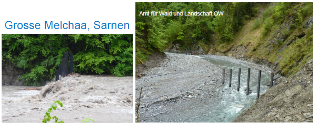
FIGURE 4.33: Exemple de grille en épi (source : GERTSCH, 2019)
