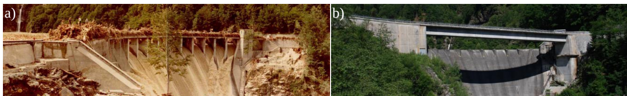
FIGURE 4.5: Adaptation de l'évacuateur de crue du barrage de Palagnedra (Suisse) : a) obstruction généralisée, surverse et contournement de l'ouvrage lors d'apports massifs en flottants en 1978 ; b) nouvelle configuration de l'ouvrage dont les piles ont été découpées (Photos de Ofima tiré de CSB, 2017)
