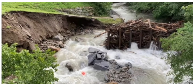
FIGURE 4.18: Exemple de râtelier pare-flottant contourné par érosion latérale pendant une crue de faible magnitude ( T \approx 2 ans?) sur la rivière Morobia en Suisse (Source : ©R. Boes - ETHZ). Une partie des flottants piégés sont restés en amont des pieux mais le bassin de l'ouvrage est globalement vide. Quelques blocs situés au centre de la photo laissent penser qu'une protection de hauteur insuffisante était située sur le côté de l'ouvrage. L'écoulement a atteint un niveau proche du haut des pieux (en témoignent les flottants piégés à cette cote) et a attaqué la berge.
