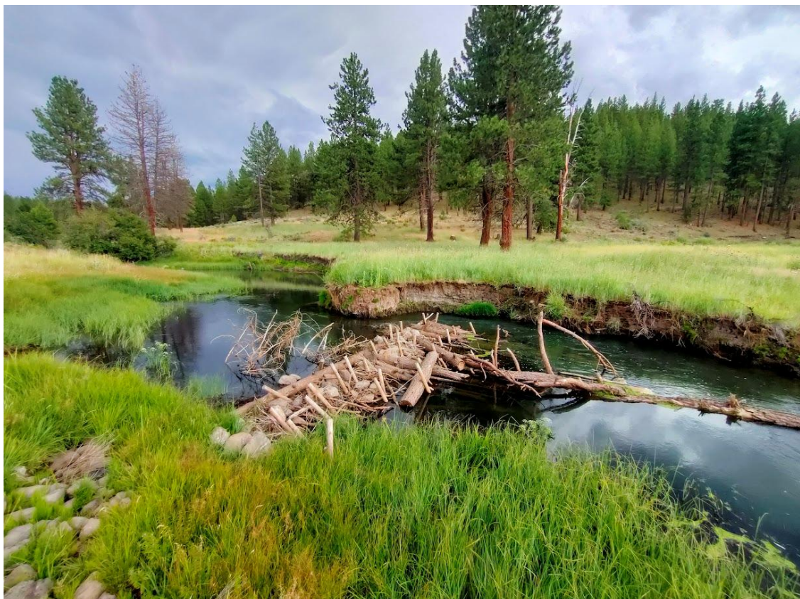
Figure 1: Exemple de structure en bois ayant pour objectif d'initier une dynamique d'érosion latérale
