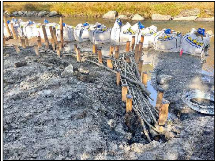
Ajout de matériaux gravelo-terreux et des branches vivantes
