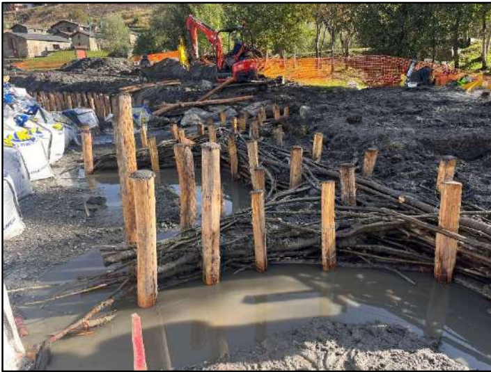
Ajout de matériaux gravelo-terreux et des branches vivantes
