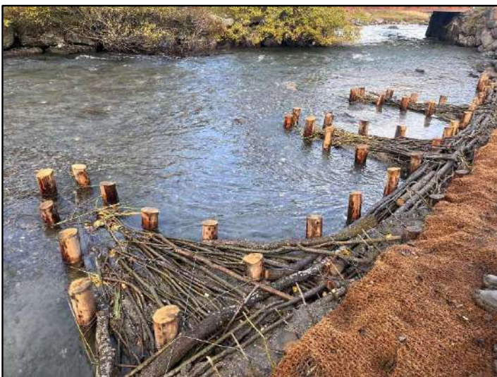
Ajout de matériaux gravelo-terreux et des branches vivantes
