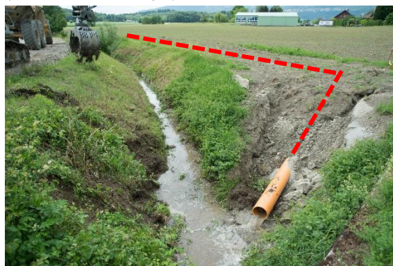
Fig. 27d : Déversement du collecteur dans l'Orpundbach. Il ne doit pas y avoir de barrage de castor en aval du déversement. (photo : Christof Angst)
